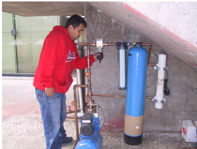
Dando mantenimiento a filtros
